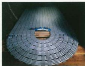
下水本管底部の下水採熱パイプ敷設状況
